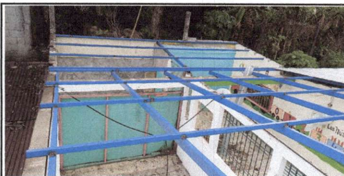
foto 5: estado actual de techo en area de bodega
