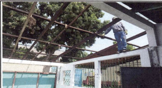
Foto 2: Desmontaje de estructura de soporte de madera
