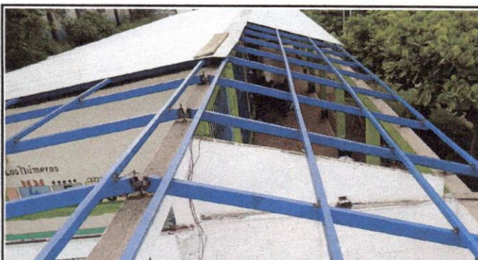
Foto 4: Proceso de instalación de techo con lámina aluzinc
