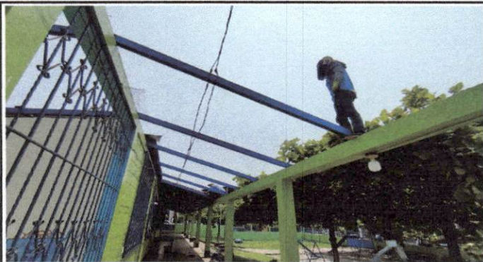
Foto1: Montaje de estructura de soporte de metal
