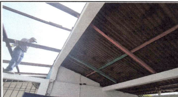
Foto 3: Desmontaje de lámina existente
