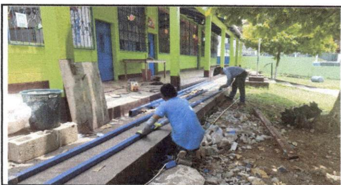
Foto 6: Montaje de estructura de soporte de metal
